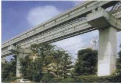
預應力混凝土梁
