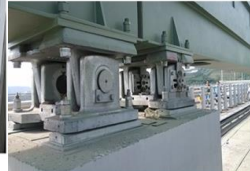
鋼軌道梁大位移鑄鋼拉力支座
