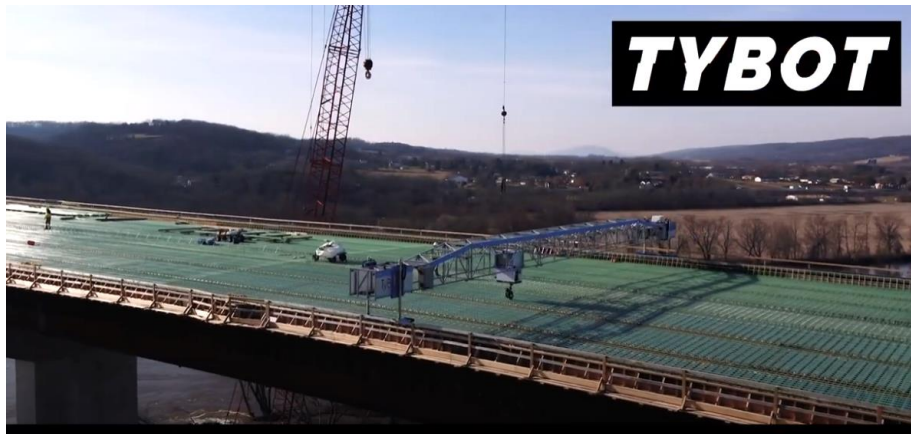
圖五 綁紮鋼筋機器人可協助執行橋梁工程施工。
