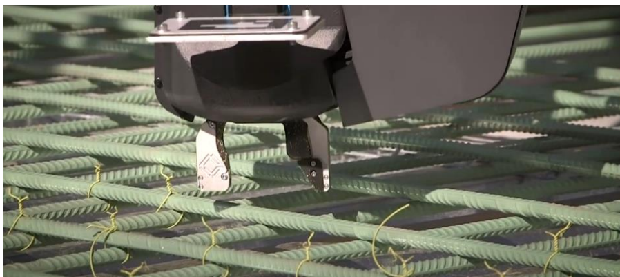
圖六 機器人進行綁紮鋼筋作業。
